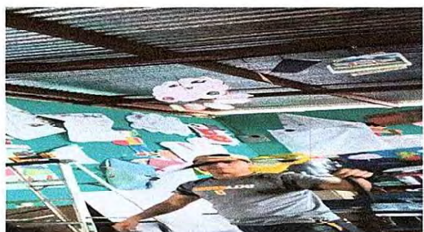
Foto 10: Sustitución del ducto electrico en aulas y accesorios.
