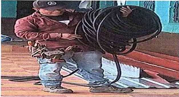
Foto 7: Iniciando el mejoramiento del sistema electrico principal (bodega, aulas, cocina y dirección) para la seguridad de los alumnos.
