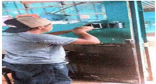
Foto 8: Mejoramiento del sistema electrico en dirección. Cambio del tablero de flipon
