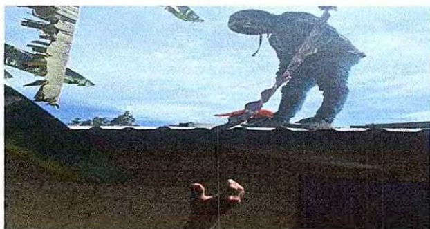
Foto 3: Continuando la sustitución de lamina acanalada por lámina troquelada aluzinc calibre 26, para mejorar las condiciones de los ambientes.
