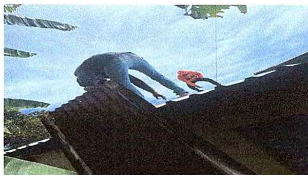
Foto 2: Continuando la sustitución de lamina acanalada por lámina troquelada aluzinc calibre 26, para mejorar las condiciones de los ambientes.
