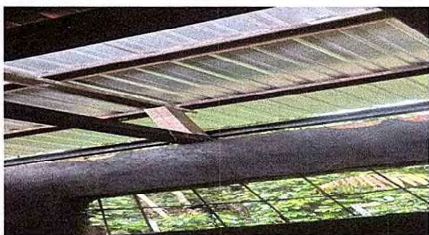
Foto 5: ontinuando la sustitución de lamina acanalada por lámina troquelada aluzinc calibre 26, para mejorar las condiciones del ambiente de la cocina.
