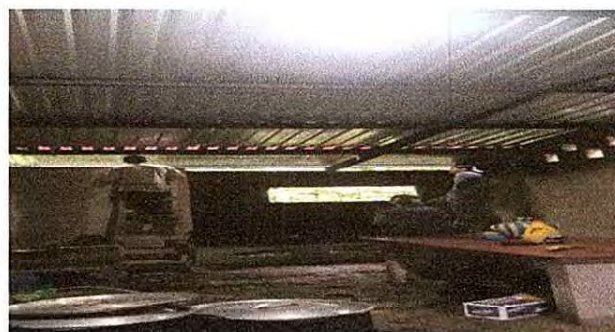
Foto 4: Continuando la sustitución de lamina acanalada por lámina troquelada aluzinc calibre 26, para mejorar las condiciones del ambiente de la cocina.
