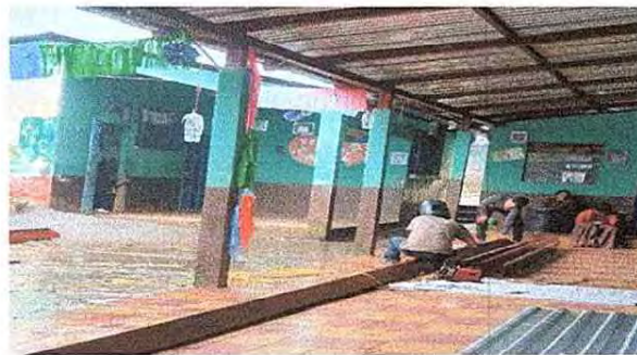
Foto 6: Trabajando con el mejoramiento del canal metálico y soporte debido al deterioro.
